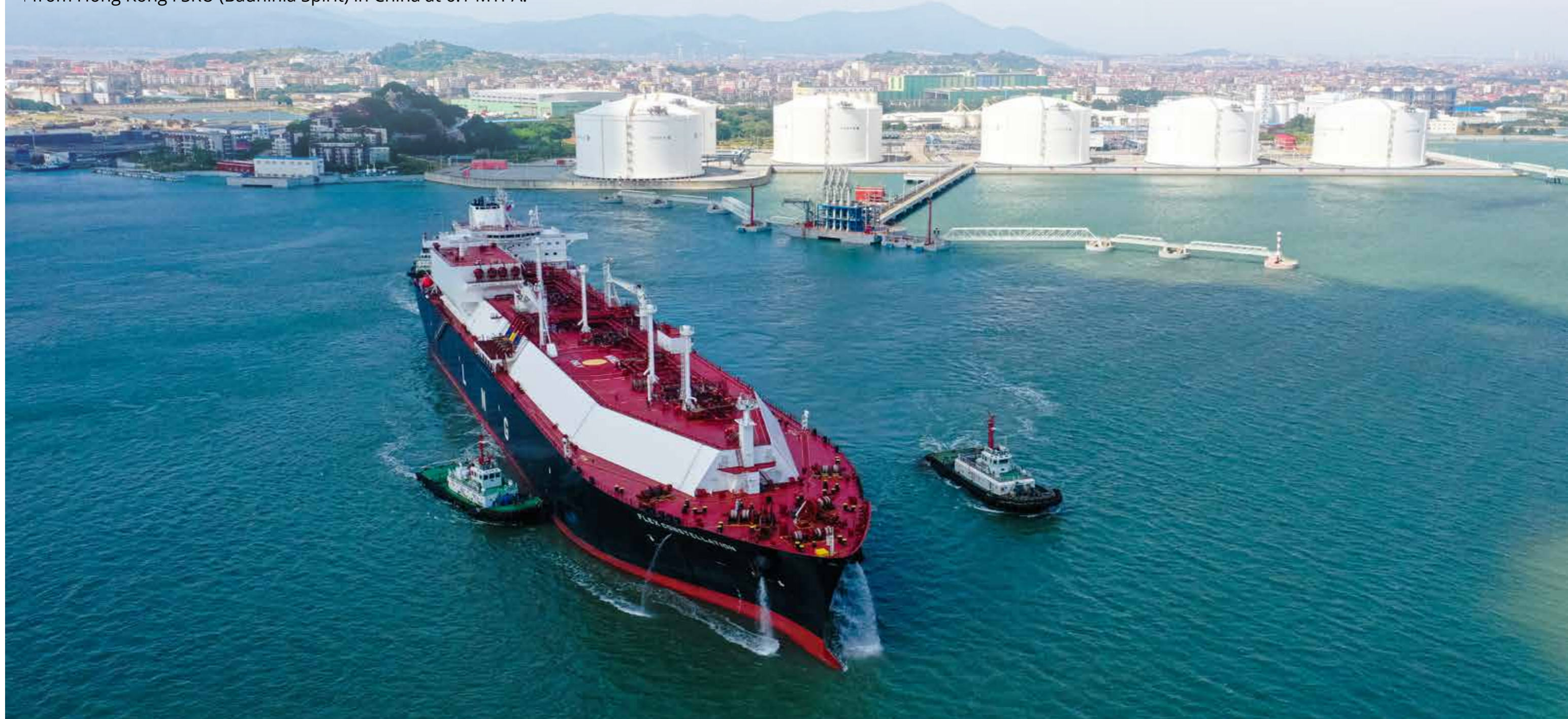
Fujian LNG Receiving Terminal - Courtesy CNOOC
